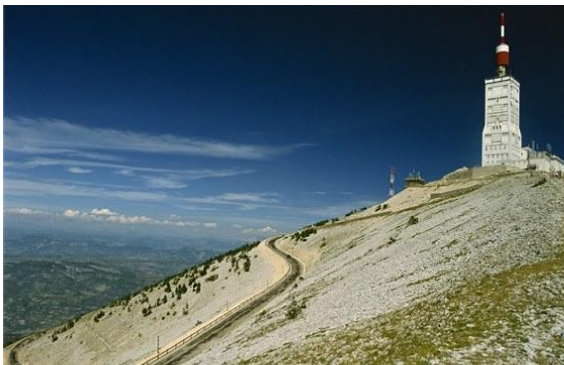
Provence, Mont Ventoux
